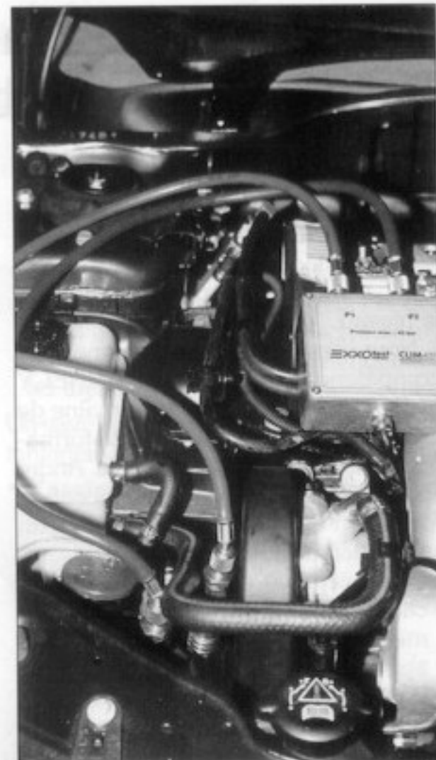
Depuis le poste de conduite lecture instantanée de 5 mesures (BP, HP, Température et hygrométrie ambiante, température sortie évaporateur)
